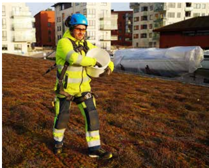
Gödsling av sedumtak.
